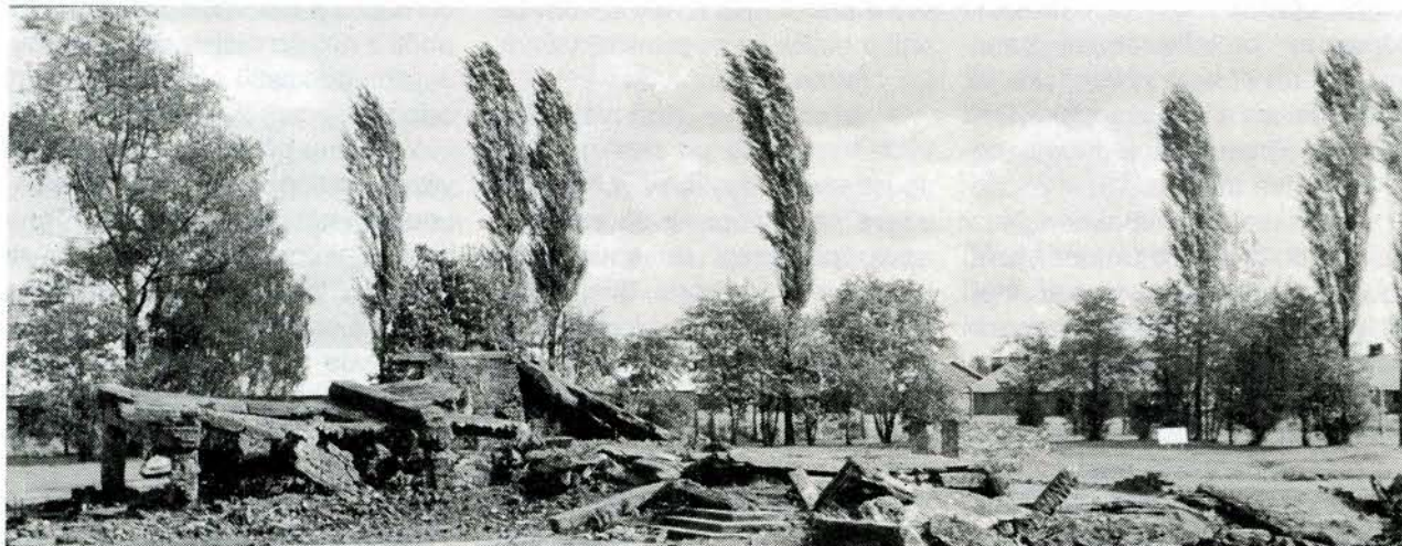
Rozvaliny krematoria a plynové komory, kde byly zavražděny tisíce vězňů terezínského rodinného tábora.
